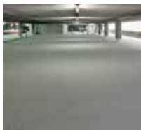
6 Infine, sigillare la superficie con Triflex Cryl Finish 209.
