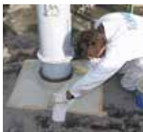
3 In primo luogo vengono impermeabilizzati tutti i dettagli con Triflex ProDetail.
