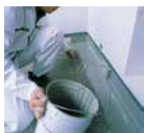
2 Stendere Triflex ProDetail sui collegamenti.
