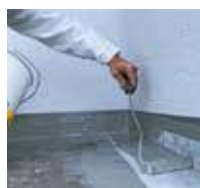
4 ... ricoprire abbondantemente con Triflex ProDetail.
