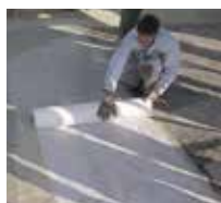
5 Il tessuto non tessuto speciale Triflex viene inserito su tutta la superficie evitando la formazione di bolle d'aria.
