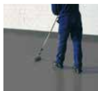
8 Viene applicata la sigillatura Triflex Cryl Finish 209.
