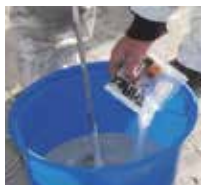
2 Prima della lavorazione, il catalizzatore Triflex viene mescolato alla resina.
