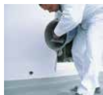
5 Applicare il rivestimento per superfici Triflex ProFloor ...
