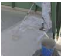
6 Viene applicato un secondo strato di Triflex ProTect.
