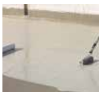
7 Un secondo strato di Triflex ProPark viene applicato fresco su fresco.
