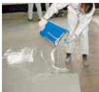
3 Applicazione della malta autolivellante Triflex DeckFloor ...
