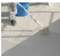
7 Se necessario è possibile sigillare la superficie dopo circa 1 ora.
