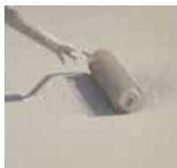
4 ... e livellamento uniforme con il rullo speciale Triflex.
