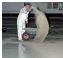
5 Il rivestimento fresco ad es. per i parcheggi può essere cosparso di sabbia.
