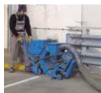
1 Pretrattamento del sottofondo, ad es. con pallinatura.
