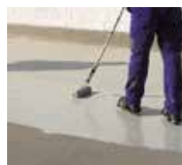
5 Sulla superficie viene applicato abbondante Triflex ProPark.
