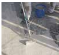
4 Sulla superficie viene applicato abbondante Triflex ProTect.
