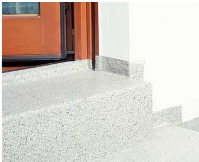
I dettagli e i giunti rappresentano un particolare punto di forza per gli impermeabilizzanti Triflex. Il materiale elastico applicato allo stato liquido si adatta subito come una seconda pelle ad ogni forma di costruzione immaginabile e impermeabilizza il sottofondo senza saldatura in modo omogeneo e continuo. Grazie ai spessori di soli pochi millimetri è possibile raccordare in modo sicuro anche porte di balconi con altezze di collegamento limitate.
